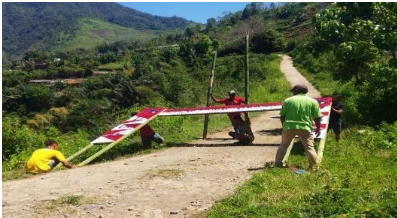
Gambar 3. Pelaksanaan pembanguna gapura
