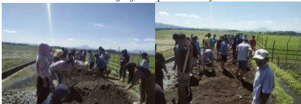
Gambar 6. Melakukan Penimbunan Tanah dan Pemadatan pada Badan Jalan
