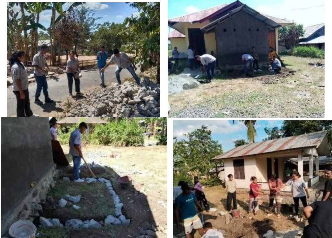
Gambar 2. Proses pembuatan Pondasi Bak Penampung Air
