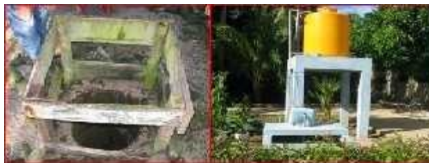
Gambar 12. Sumber air sumur dangkal untuk MCK di lokasi pantai barat (kiri) dan lokasi kompleks sekolah SMP dan SMA di pantai timur
