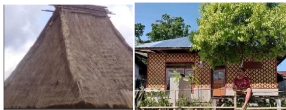
Gambar 16: Penggunaan Material Lokal Sumber: Dokumen Pribadi, 2022
