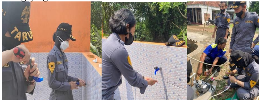
Gambar 9. Proses instalasi pompadan perpipaan.
