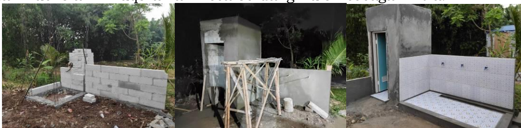
Gambar 7. Proses pekerjaan bangunan kamar kecil dan tempat wudhu
