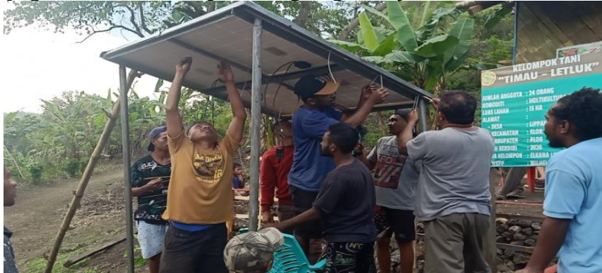
Gambar 2. Pemasangan system PLTS oleh tim
