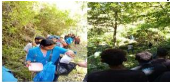
Gambar 3. Pembersihan Lokasi Pembuatan Bak Penampung Air
