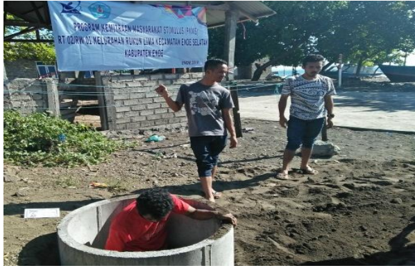
Gambar 5. Penggalian Sumur Resapan
