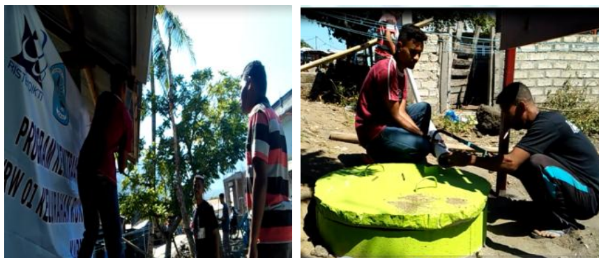
Gambar 7. Pemasangan Talang dan Pemanjambungan Pipa Paralon
