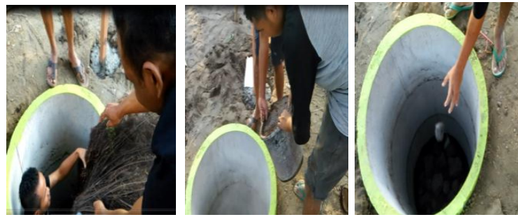
Gambar 6. Memasukan Ijuk, Pasir, dan Batu ke Dalam Sumur Resapan
